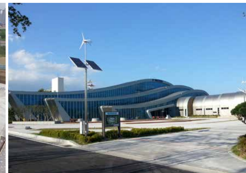
(좌) 파주시 하수재이용시설, (우) 포항시 하수재이용시설 전경
