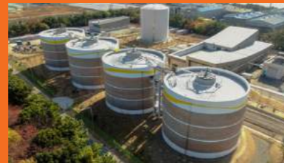
국내 첫 AMX 상용화 성공... 부산 녹산하수처리장 소화조 반류수 처리시설 준공
