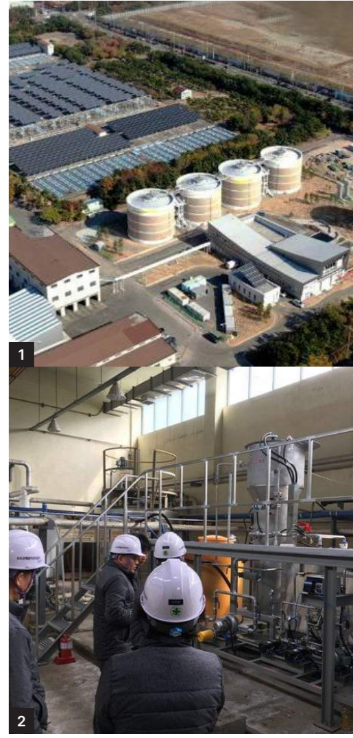
1. 부산 녹산하수처리장 반류수 처리시설 2. 수도권매립지공사 AMX 적용성 공동연구 현장
